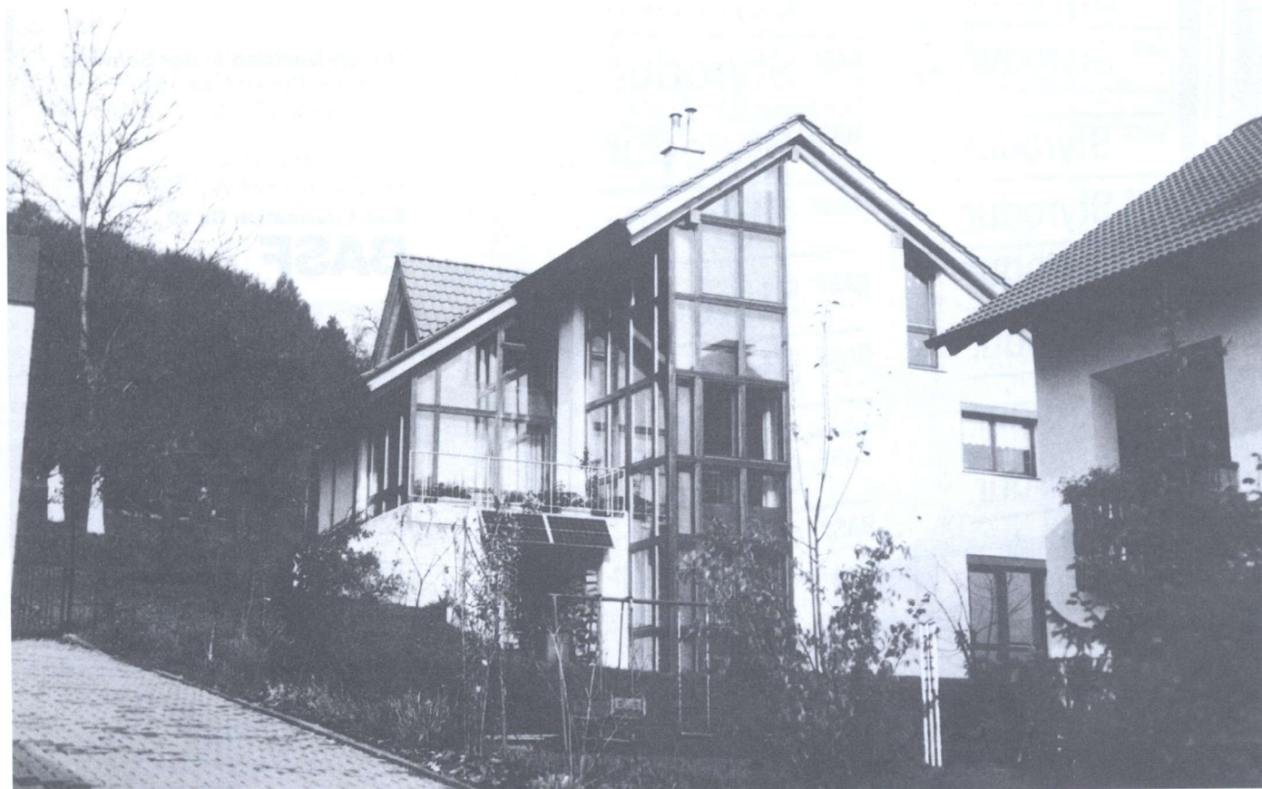
Der 40 m 2 grosse Fensterkollektor mit einer (grössten) Höhe von 11,5 m. Links die Solarzellenanlage (2 m 2 ).
