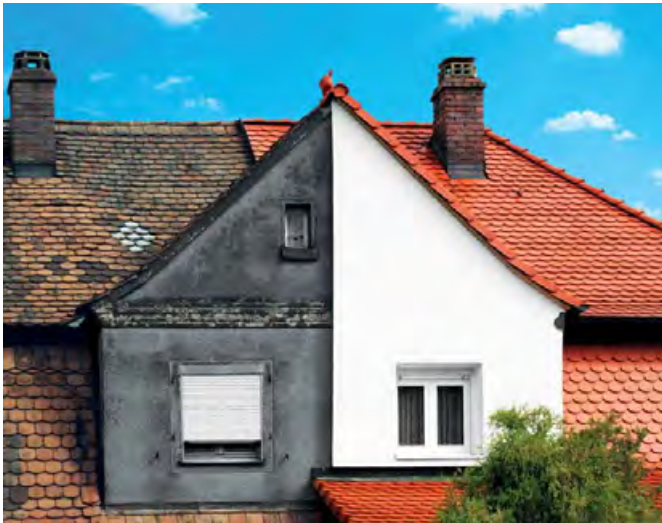
Die energetische Gebäudesanierung ist ein entscheidender Faktor für den Klimaschutz
