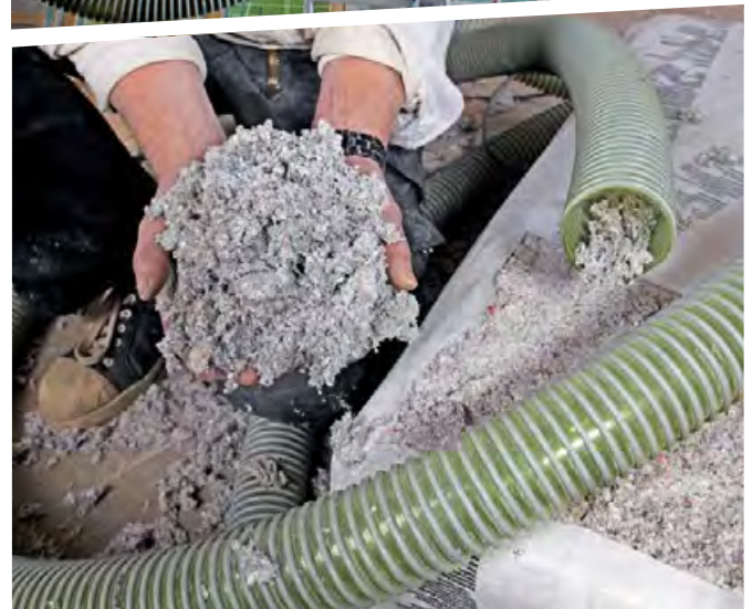
Einblasdämmung von Zellulose
