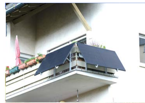
Bild: Balkon-Solar, Quelle: Stry-Hipp
